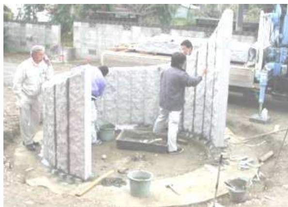
観月苑の工事
